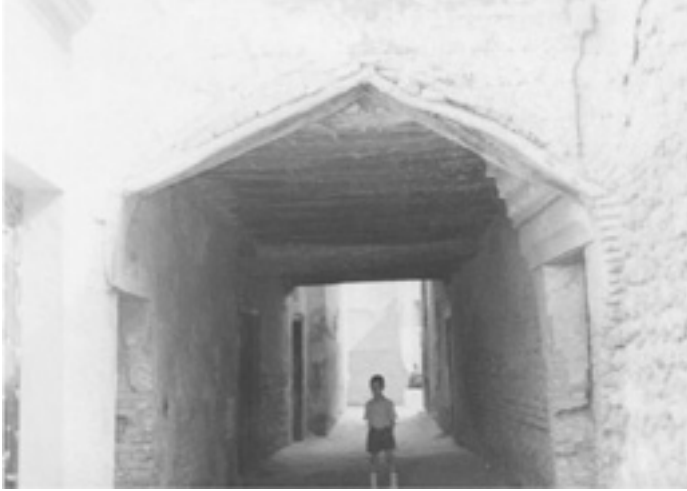
الصورة (7) سقيفة غير مقوسة: يسمح للمارة من استعماله دون حرج السقيفة: استعمال ذكي وناجع للفضلاء العلوية بعد استئذان المحتسبو القائمين على متابعة الخطة
